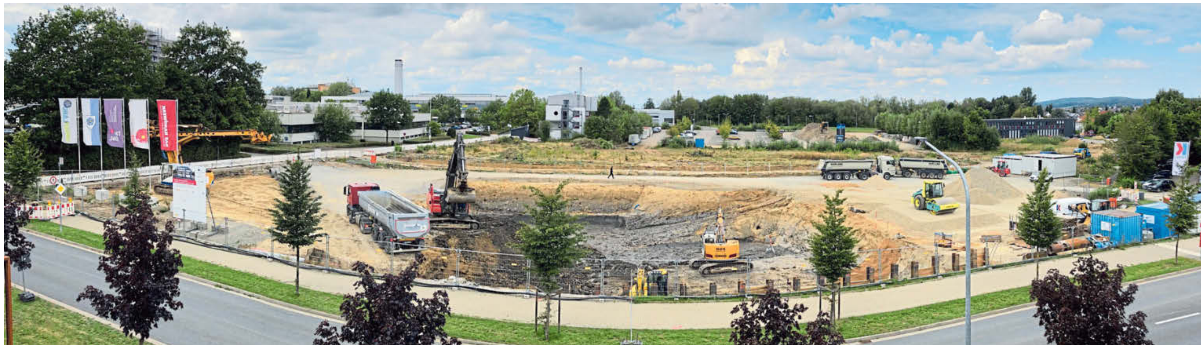
Der Innovation-Campus ist zur Großbaustelle mutiert. Bei einigen Anliegern liegen deshalb die Nerven blank.
